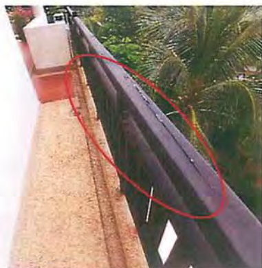
งาน ลูกกรงไม้ มีรอยแตกหักชำรุด
