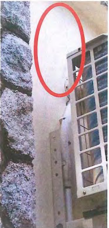
รูปภาพการสำรวจอาคารสำนักงาน ห้องเครื่อง ส่วนใหญ่เกิดรอยร้าวและมีรอยร้าวจากด้านบน หลังคาห้องเครื่องซึ่งเป็นพื้นคอนกรีต
