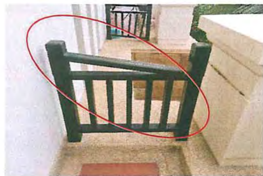
ลูกกรงไม้หลุด
