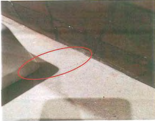
รอยร้าวบริเวณTOP หิน เคาท์เตอร์อ่างล้างหน้า
