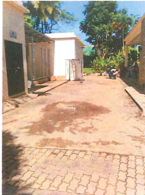
บริเวณที่ตั้งหม้อแปลงไฟฟ้า มีรอยร้าวตามรูป พื้นทรุดตามสภาพใช้งาน
