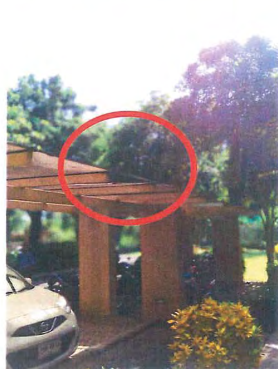
ที่จอดรถอาคาร 3 - 4 เป็นหลังคาโพลีคาร์บอเนตชำรุดจากการใช้งานตามรูป ผนังทรายล้างไม่เรียบร้อย
